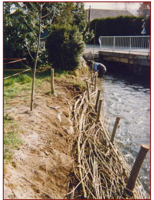
Mise en place de caisson végétal
